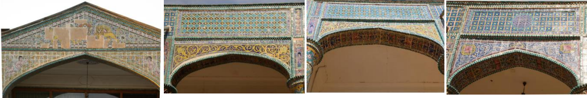
تصویر ۷: بخشی از کاشی‌کاری نمای جنوبی طبقه دوم عمارت مفخم (مأخذ: نگارندگان)
