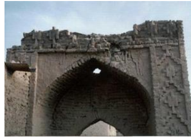
تصویر ۳۸: نمای سردر آب‌انبار و آجرکاری هندسی آن. مأخذ:
