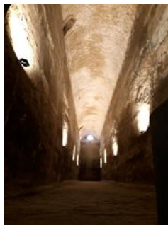
تصویر ۷: فضای ذخیره آب و مخزن
