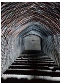
تصویر ۱۱: پلکان ورودی آب‌انبار خان
