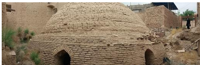
تصویر ۳۱: پوشش منبع ذخیره آب در آب‌انبار
