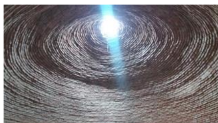
تصویر ۳۰: سقف مخزن آب‌انبار
