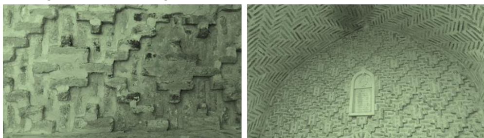
تصویر ۲۳: کاربندی‌های آجرکاری هندسی و کتیبه آب‌انبار حاج محمدخان
