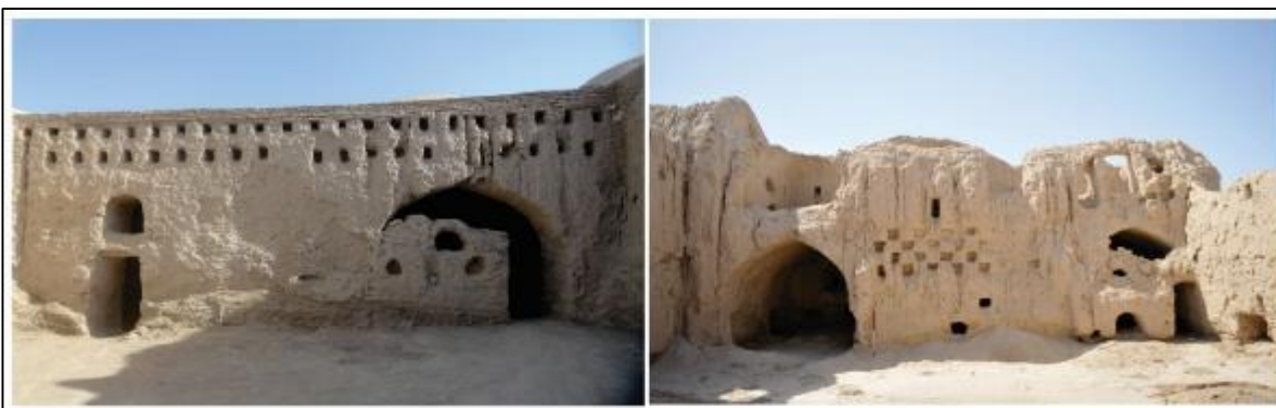
تصویر ۱۶: استفاده از ایوان‌های شاه‌نشین به‌عنوان اتاق، با استفاده از ایجاد دیوارک بر دهانه آن (مأخذ: نگارندگان)
