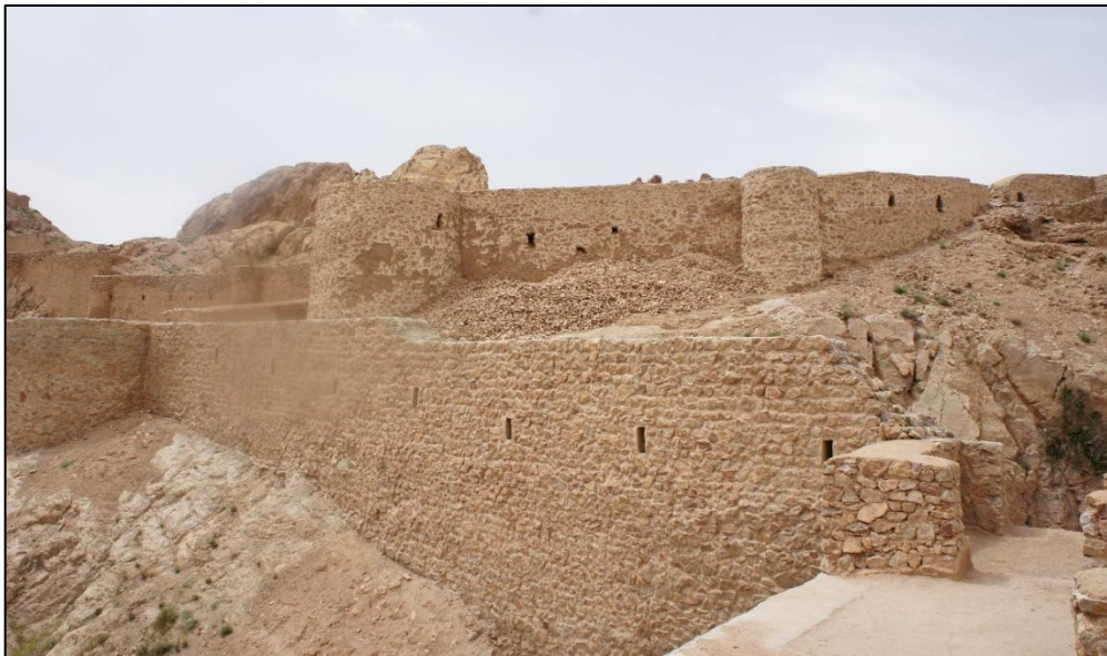
تصویر ۶. حصار و برج‌ها و قرارگیری تیرکش‌ها در حصار و برج‌ها ماخذ: نگارندگان
