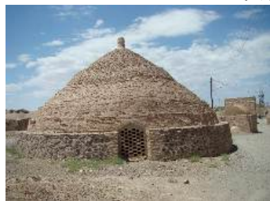
تصویر ۶ مخزن آب‌انبار با سقف گنبدی و روزنه آن (نگارندگان، ۱۳۹۲)
