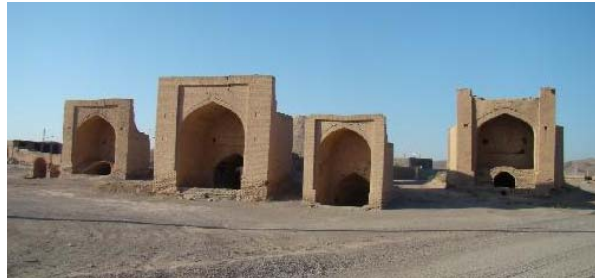
تصویر ۹ نمای جنوبی آب‌انبارهای خانکوک (نگارندگان، ۱۳۹۲)
