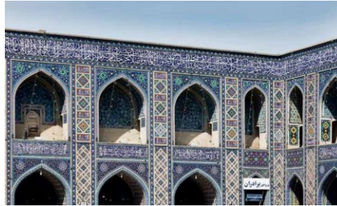
تصویر ۱۳: طاغچه‌بندی‌های بدنه نمای غربی مسجد گوهرشاد (صحرانگرد، ۱۳۹۲: ۱۵۰)
