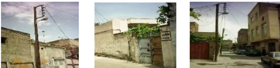
شکل ۱۴. عبور نامطلوب کابل های برق با توده های گیاهی و نصب لوله های گاز در جداره خارجی ساختمان ها بر دامنه خطرهای ناشی از آتش سوزی می افزاید ماخذ: نگارندگان
