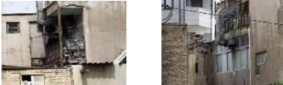
شکل ۱۵. عناصر الحاقی سست و ناپایدار در نمای ساختمان ها به تشدید آسیب پذیری محیط میانجامد ماخذ: نگارندگان
