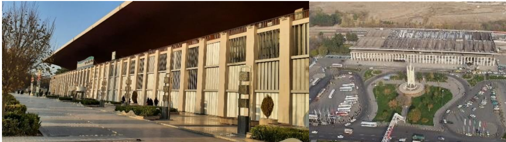
تصویر ۱۰: عکس هوایی از نمای ورودی بنای ایستگاه راه‌آهن (مأخذ: نگارندگان). صفحات آلومینیومی متحرک در بخشی از نمای اصلی (علاوه بر کاربرد اقلیمی نقش مهمی در ایجاد حریم و حجاب برای عملکردهای داخل بنا دارند) (مأخذ: نگارندگان)
