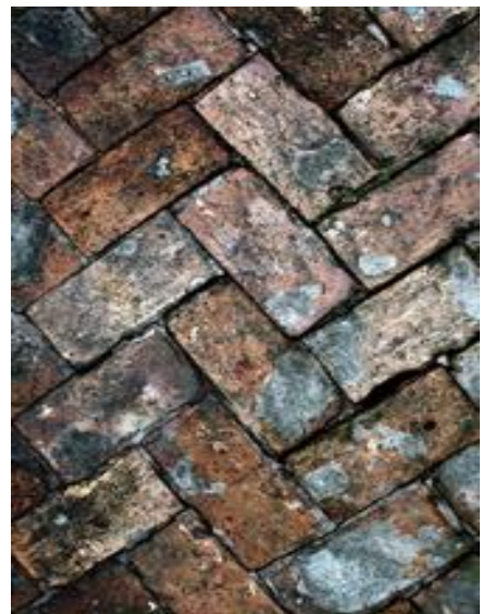
تصویر ۳. کفپوش آجری (ویکی‌پدیا، ۱۳۹۶)
