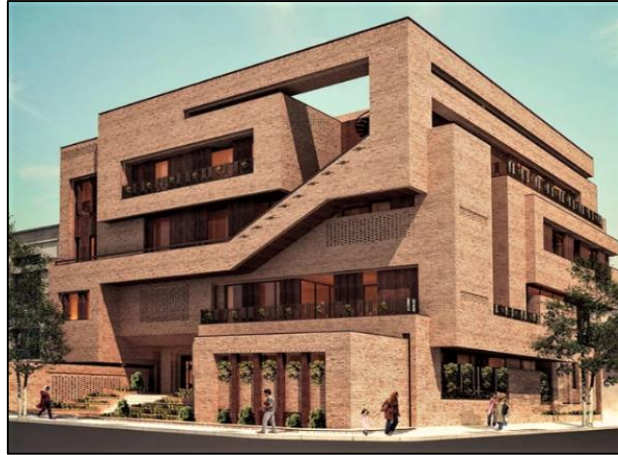
تصویر ۱۸: استفاده اقتصادی از آجر (منزل قدس) (مأخذ: آرشیو دفتر آبار)
