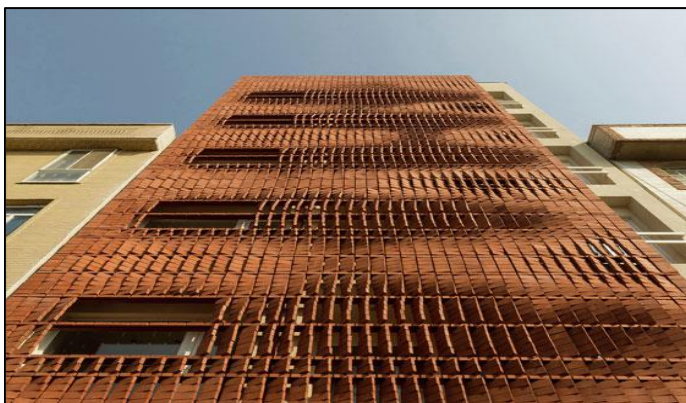
تصویر ۱۲. استفاده پوسته‌ای از آجر (ساختمان آجر پوش) (حسینی و سیدین، ۱۳۹۵: ۲۱۹)
