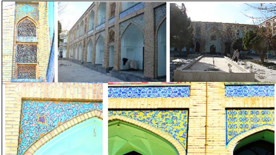
مجموعه تصویری ۷: بالا از راست: نمایی از مدرسه با ایوان جنوبی، جبهه شرقی و غربی، بالای پلکان به طبقه اول مدرسه. پایین: کاشی هفت‌رنگ در لچکی حجره‌ها در طبقه همکف و اول مدرسه خیرات خان (همان)
