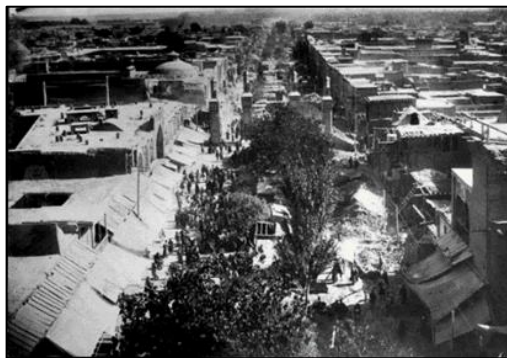
تصویر ۲۲: پایین‌خیابان در جریان عملیات ساختمانی دکان‌ها در نیمه نخست دوره پهلوی اول (ساکماق، ۲۴۴۸۷)
