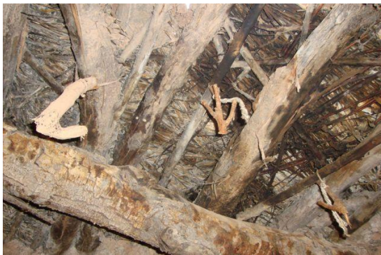
تصویر ۴. تعبیه آویز در سقف فضای ورودی،
