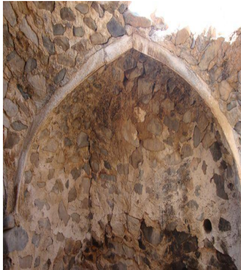
تصویر ۸. نمایی از اجرای گنبدی سقف خانهٔ آسیاب
