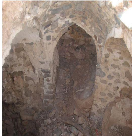
تصویر ۷. نمایی از اجرای گنبدی سقف خانهٔ آسیاب
