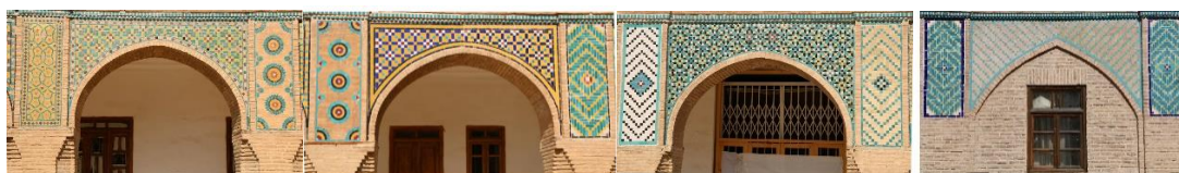
تصویر ۶: بخشی از کاشی‌کاری نمای جنوبی طبقه اول عمارت مفخم (مأخذ: نگارندگان)
