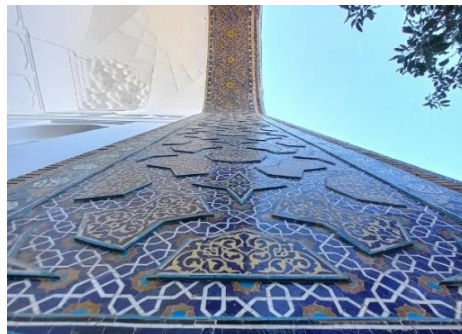
تصویر ۸: تزیینات کاشی‌کاری ایوان اصلی در معماری آرامگاه شیخ احمد جام
