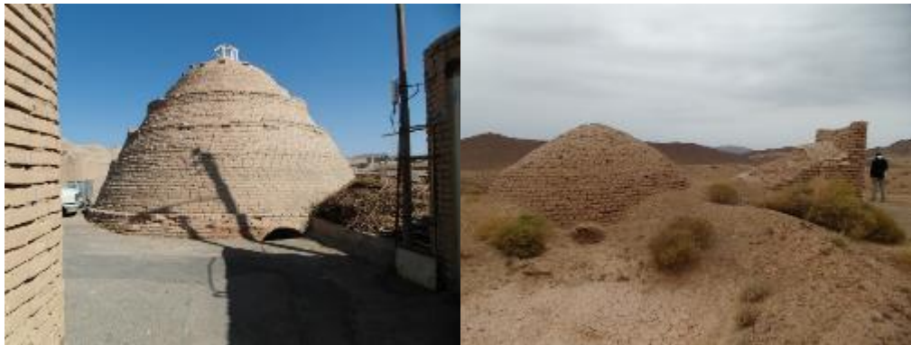
تصویر ۱۰: نمونه‌هایی از آب‌انبارهای گنبدی آجری خوسف (مأخذ: نگارندگان)
