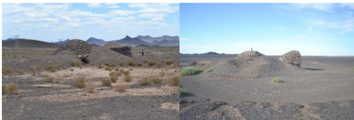
تصویر ۸: دو نمونه از آب‌انبارهای گنبدی لاشه‌سنگی خوسف (مأخذ: نگارندگان)
