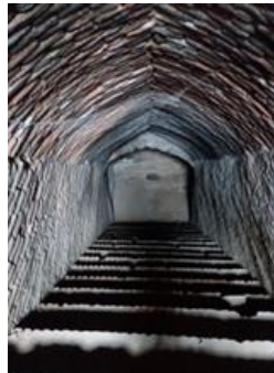
تصویر ۱۱: پلکان ورودی آب‌انبار خان
