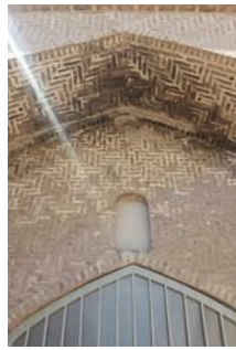
تصویر ۶: آجرکاری نمای ورودی
