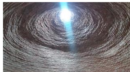
تصویر ۳۰: سقف مخزن آب‌انبار
